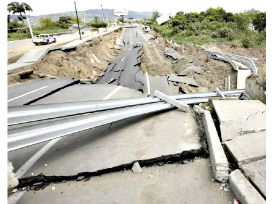
Puente destruido, terremoto Costa Norte, 2016 Fuente: Reuters Media Express
