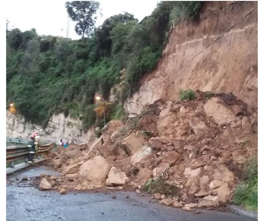
Derrumbe Quito, 2015. Fuente: Medios públicos
