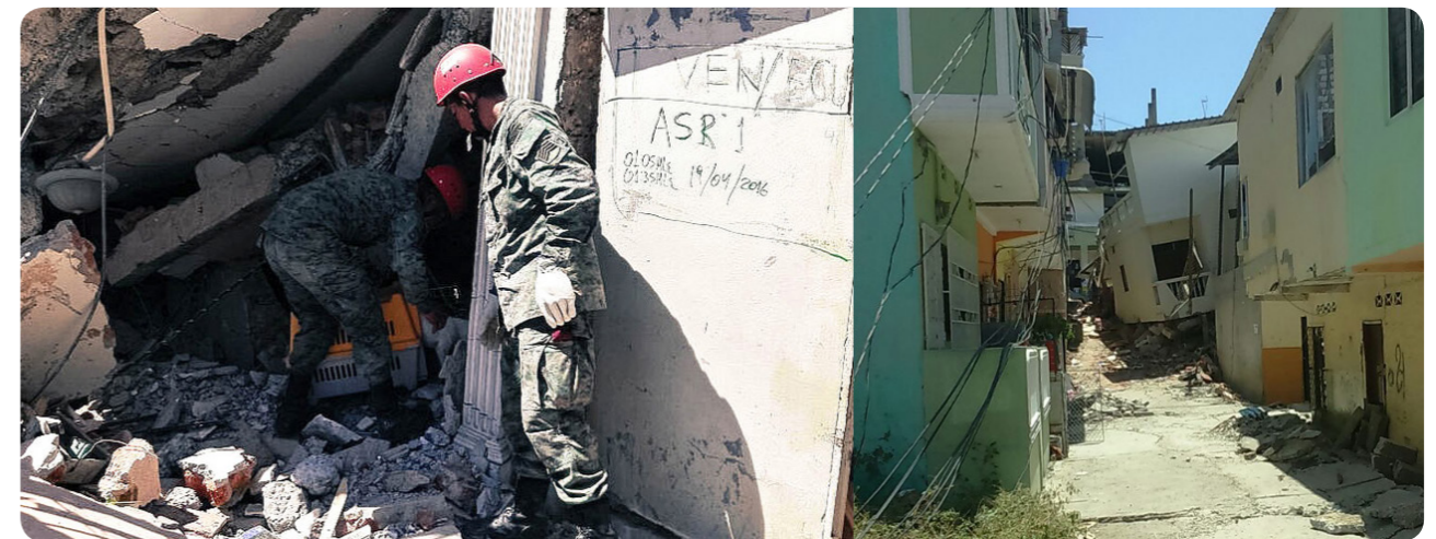
Edificaciones Destruídas Fuente: Ejército Ecuatoriano - IGM
