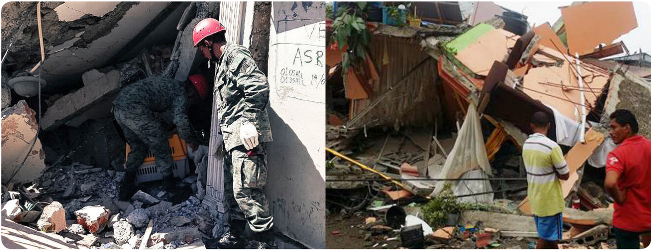
Edificaciones Destruídas Fuente: Ejército Ecuatoriano / El Comercio -2016
