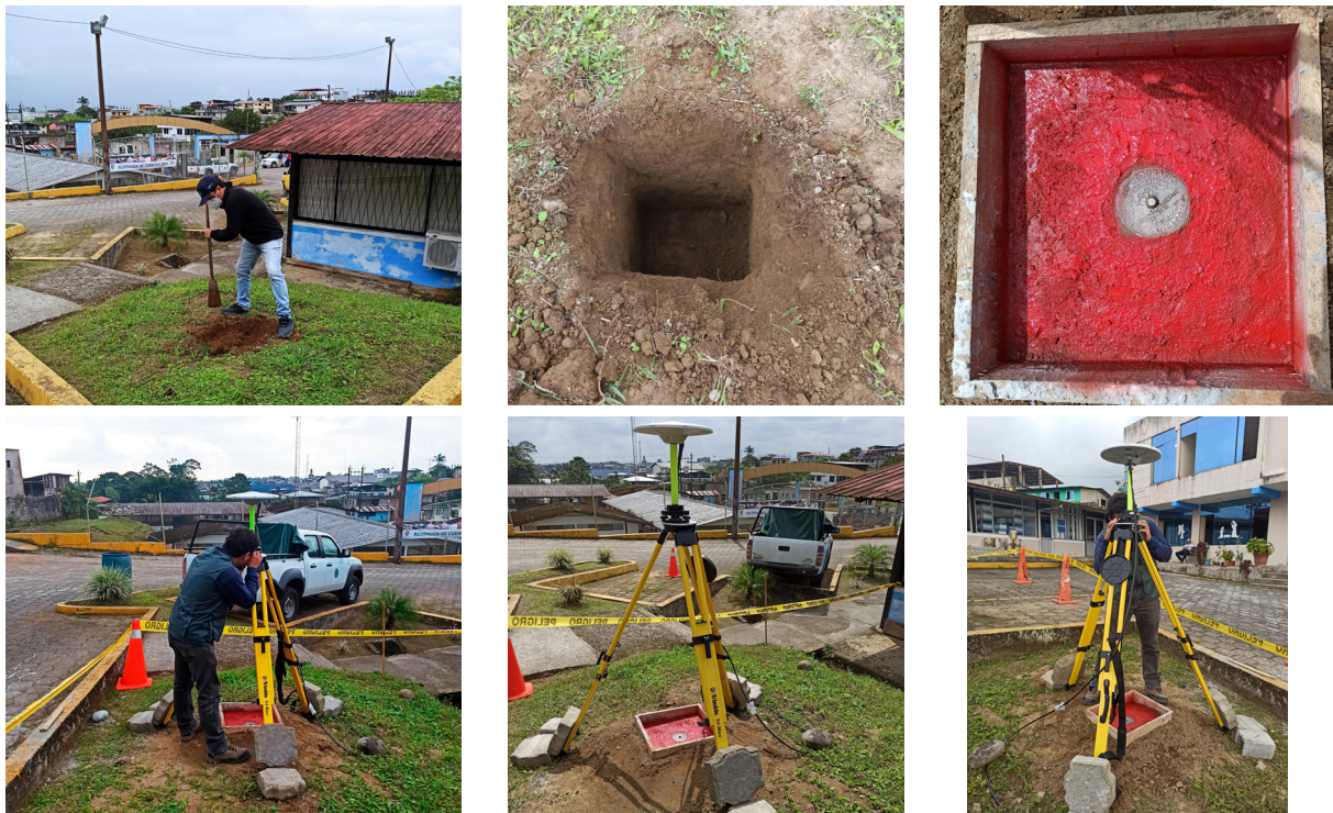
Figura 1: Construcción del Mojón IGM tipo B, GADM. Pedro Vicente Maldonado, 2021
