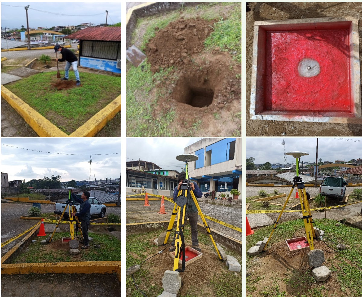
Figura 5. Construcción de un mojón IGM tipo B en el GADM Pedro Vicente Maldonado (2021).
