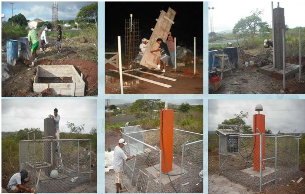
Figura No. 13: Instalación de una estación GNSS permanente - REGME.
