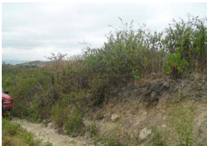
Foto 44. Coluvión Antiguo (Can). Sector: Aguas Nuevas. 2011
