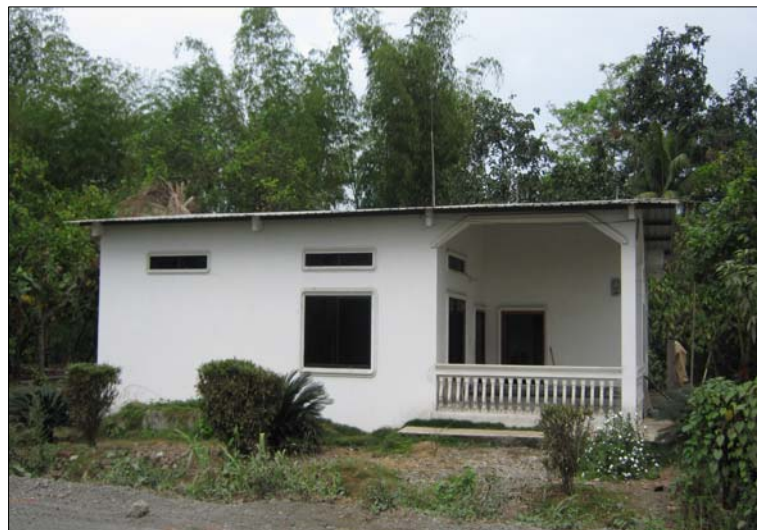
Foto 8. Vivienda de hormigón, vulnerabilidad baja Fuente: CLIRSEN 2010
