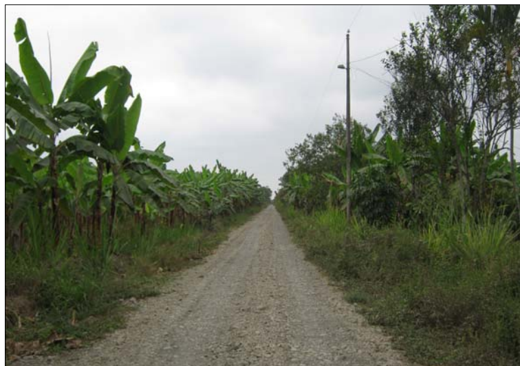
Foto 3. Camino lastrado de una vía Fuente: CLIRSEN 2010
