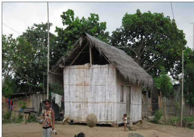
Foto 6. Vivienda de caña guadúa, vulnerabilidad muy alta Fuente: CLIRSEN 2010
