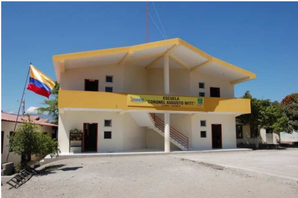
Foto 11. Bloque de aulas de la Escuela Coronel Augusto Witt, Sitio La Vega, Catamayo Fuente: UTPL, 2011
