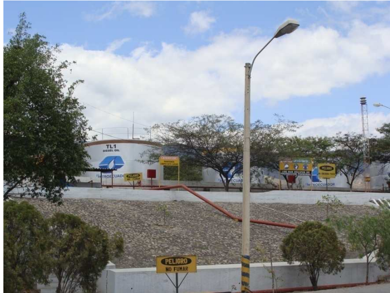
Foto 21. Depósito La Toma EP Petroecuador, Catamayo Fuente: UTPL, 2011
