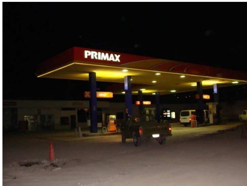
Foto 18. Estación de servicio Gasosilva Catamayo, Catamayo. Fuente: UTPL, 2011.
