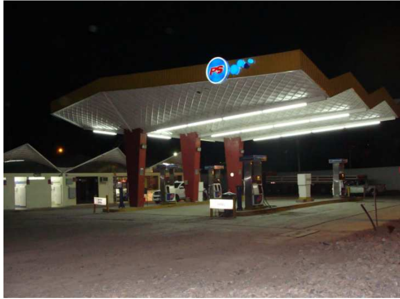
Foto 17. Estación de servicio El Castillo, Catamayo. Fuente: UTPL, 2011.
